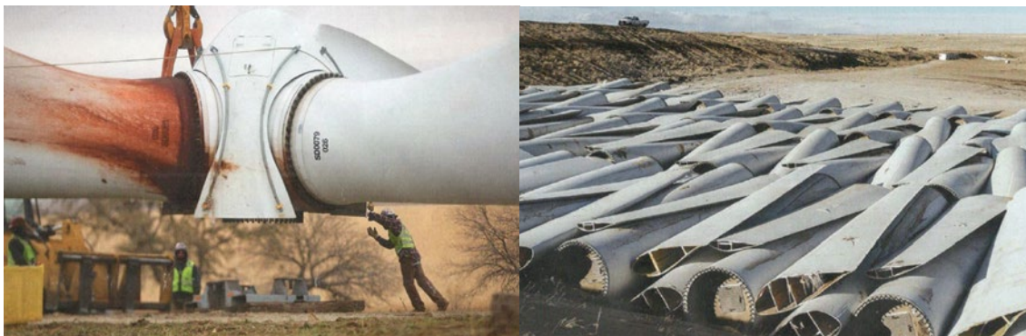
Рис. 4. Демонтаж отработавших лопастей ветровых генераторов и кладбище лопастей, изготовленных из неподдающихся разложению композитных материалов [12].
