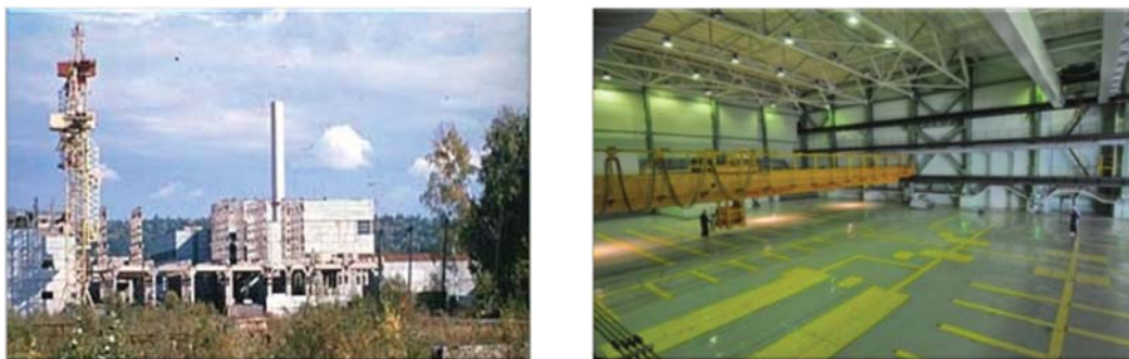
Рис. 2. Строительная площадка завода РТ-2, «мокрое» хранилище ОЯТ ВВЭР-1000.
