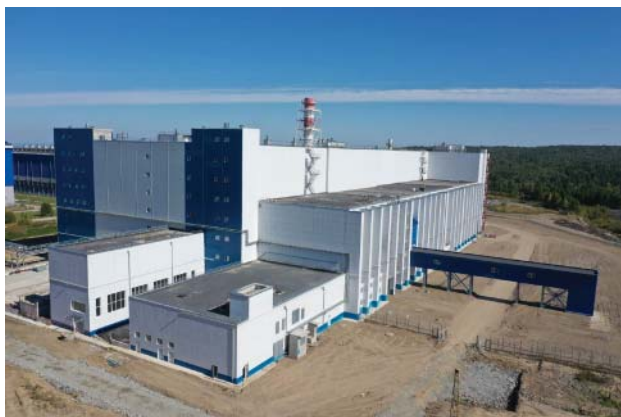
Рис. 5. Опытно-демонстрационный центр (ОДЦ) по переработке ОЯТ на ГХК.
