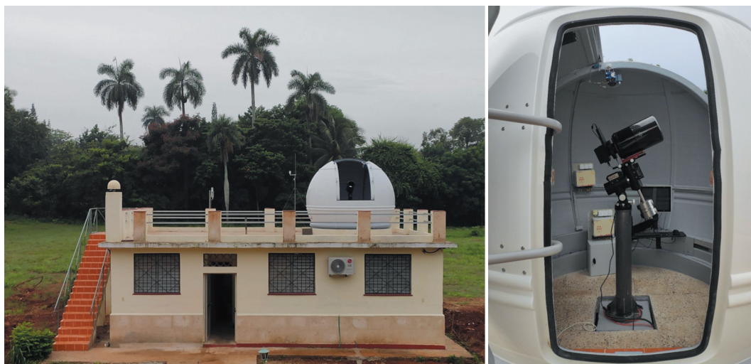
Рис. 1. Слева: общий вид российско-кубинского наблюдательного пункта в ИГА. На крыше 1-этажного помещения размещаются автоматизированный купол с 20-см телескопом оптической станции (в правой части крыши) и приемник колоцированной геодинимической станции (на бетонном столбике в левой части крыши). Справа: снимок широкоугольного 20-см робот-телескопа, установленного в куполе оптической станции.
