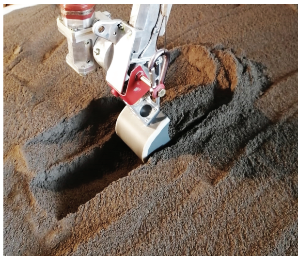
Рис. 8. Формирование двух траншей при заглаблении ЛМК в грунт.
