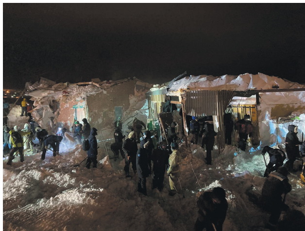
Рис. 3. Высота завалов на месте проведения поисково-спасательных работ превысила 5 м, что отчетливо видно по характеру лавинных отложений на застройке ( https://news.myseldon.com/ru/news/index/243574139 ).
