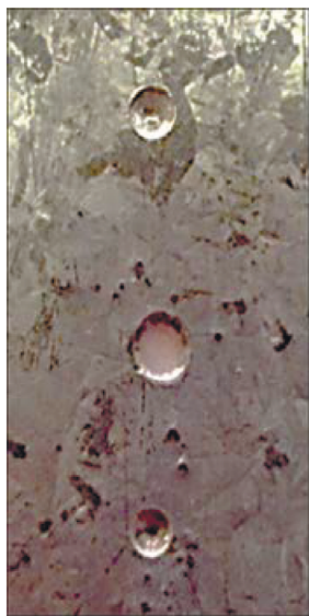
Рис. 1. Фотография пластины из оцинкованного железа с дефектами (сверху вниз): первый — диаметр 2 \cdot 10^{-3} м, глубина 3 \cdot 10^{-4} м; второй — сквозной диаметром 2 \cdot 10^{-3} м; третий — конус в основании 1,5 \cdot 10^{-3} м глубиной 2 \cdot 10^{-4} м.
