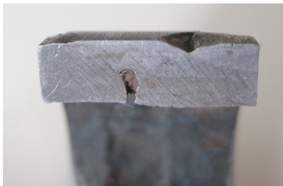
Рис.13. Образец сварного соединения \varnothing 32 \times 4 мм: свищ, заполненный отложениями.
