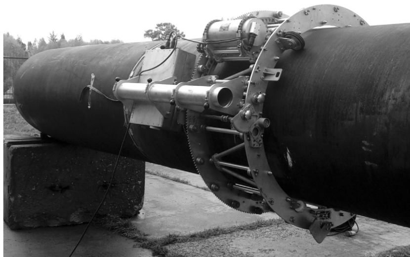
Рис. 4. Проведение неразрушающего радиоскопического контроля кольцевого сварного соединения трубопровода Ду 1000 мм с использованием АМД.
