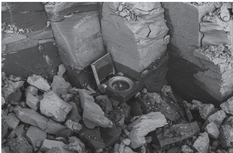
Рис. 4. Система ортогональных трещин кембрийских глин в борту карьера на абс. отметках от 0 до +15 м.
