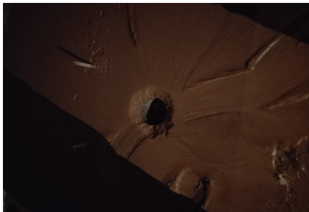
Рис. 5. Формирующийся конус выноса из пылеватых и глинистых частиц вокруг скважины, расположенной на поверхности фундаментной плиты, псевдо-вулканической суффозией на исследуемом объекте.
