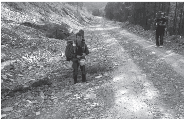
Рис. 2. Исследуемый участок с иллюстрацией размыва полотна дороги эрозионными процессами (фото Н.А. Гурьянова).
