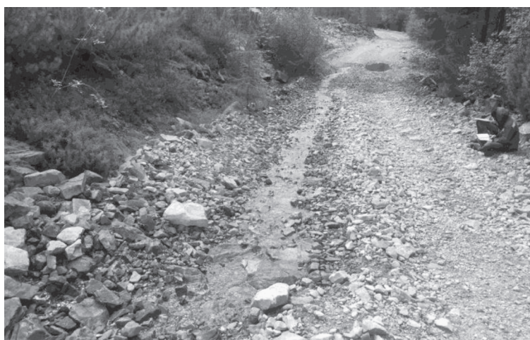
Рис. 3. Выход надмерзлотных вод из-под курумового чехла на десятом километре дороги (фото Н.А. Гурьянова).
