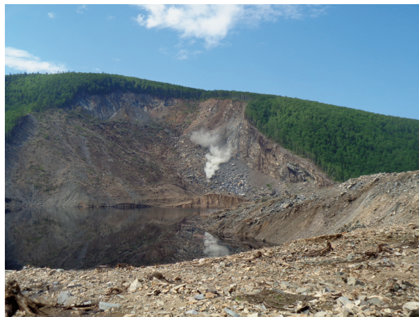
Рис. 7. Камнепад на западной стенке срыва Бурейского оползня (20 июня 2019 г.).
