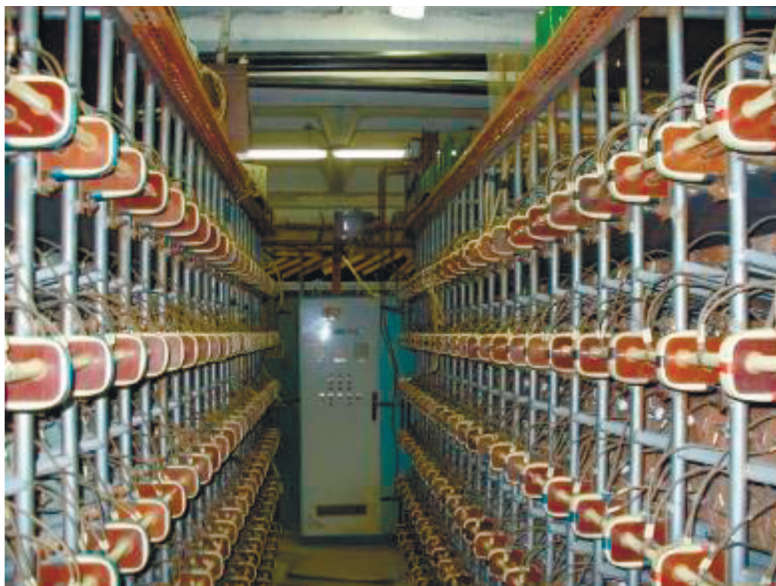
Рис. 26. Стеллажи конденсаторной батареи.
