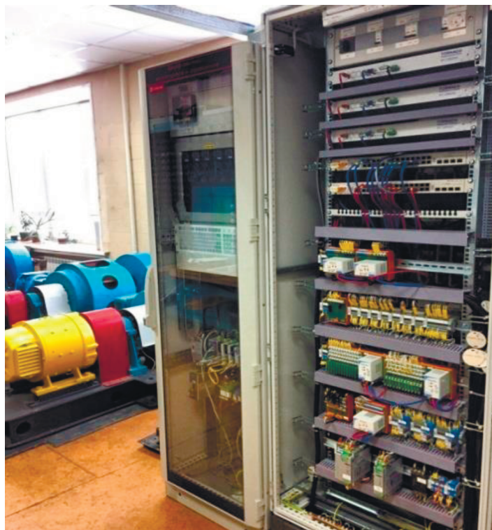
Рис. 8. Общий вид автоматика Minigrad в Центре испытаний устройств контроля и управления режимами электроэнергетических систем Новосибирского государственного технического университета.
