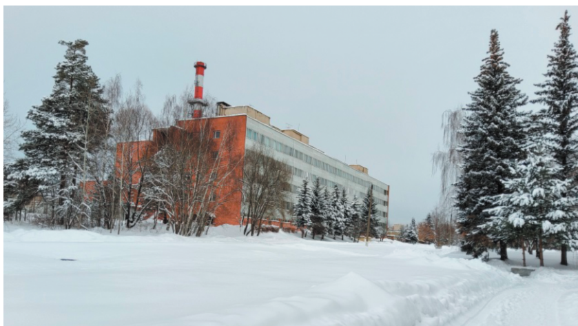
Рис. 2. Комплекс зданий “Бустер”.
