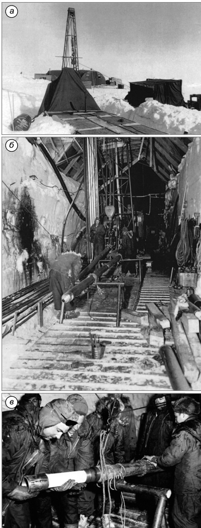
Рис. 3. Буровой лагерь на станции Site 2 в 1957 г. (а), буровая в снежной траншее (б) [4], сотрудники SIPRE достают 10-сантиметровый ненарушенный керн из бура на станции Site 2 (в). Фото из архива CRREL
