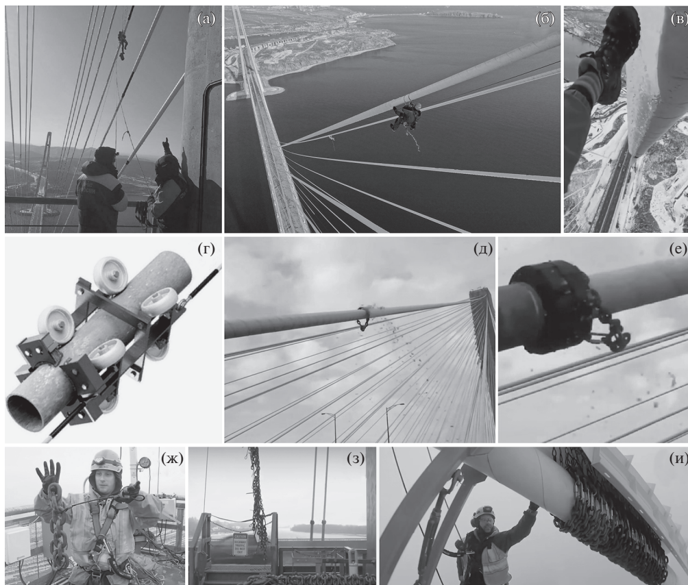
Рис. 2. Ручная (а)–(в) и механизированная (г)–(и) очистка вант промышленными альпинистами: (а), (б) – общий вид на очистку вант Русского моста со страховкой с пилона; (в) – общий вид на обледенелую ванту Русского моста ( https://www.fontanka.ru/2020/11/26/69579253/ ); (г) – общий вид вантовой снегоуборочной каретки; (д) – цепная воротниковая система в действии; (е) – цепной воротник в конце падения; (ж) – общий вид цепного воротника; (з) – подъем отработанных цепных воротников на верхнюю площадку пилона для повторного использования; (и) – установка цепных воротников на подвеске в верхней части ванты.
