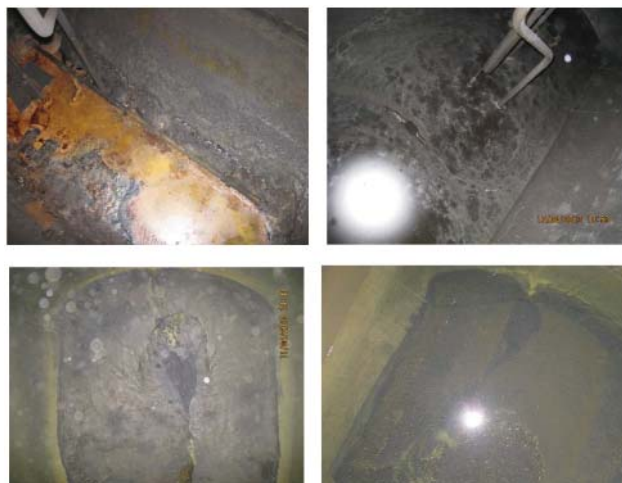
Рис. 2. Фотоизображения отложений в емкостях.
