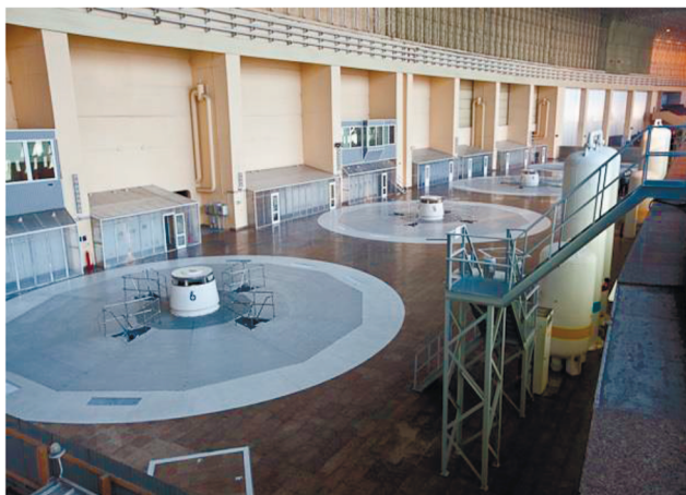
Рис. 10. Машинный зал Саяно-Шушенской ГЭС.
