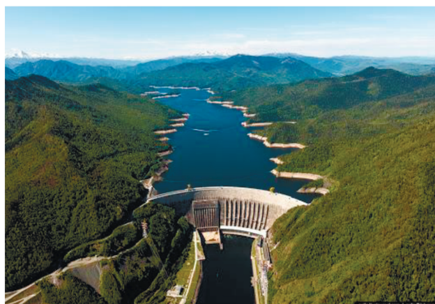
Рис. 3. Общий вид Саяно-Шушенской ГЭС.
