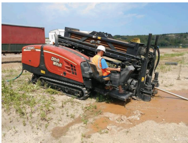
Рис. 1. Гражданская установка ГНБ.
