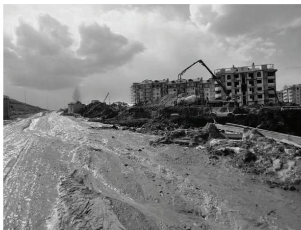
**Рис. 3.** Поток воды с высоким содержанием взвешенных веществ и нефтепродуктов на участке строительства автодороги в обход г. Одинцово (весна 2013 г.). Пример идентификации источника диффузного загрязнения, полученной путем визуального обследования водосборной территории р. Чаченки (бассейн р. Москвы).
