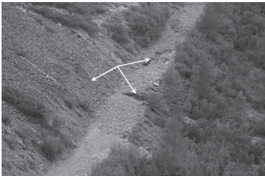
Рис. 7. Размыв полотна и нагорного откоса дороги Удокан—Наминга в 2018 г. на участке их пересечения полосами под-поверхностного стока (показаны стрелками) (фото Д. Сергеева).
