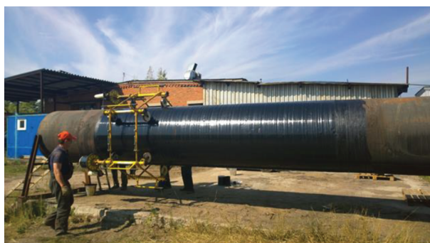
Рис. 9. Проведение стендовых адгезионных испытаний на производственной базе ООО “Делан”.
